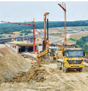
Katzenbergtunnel zu Beginn der Bauarbeiten. Bild: www.dietmar-strauss.de
