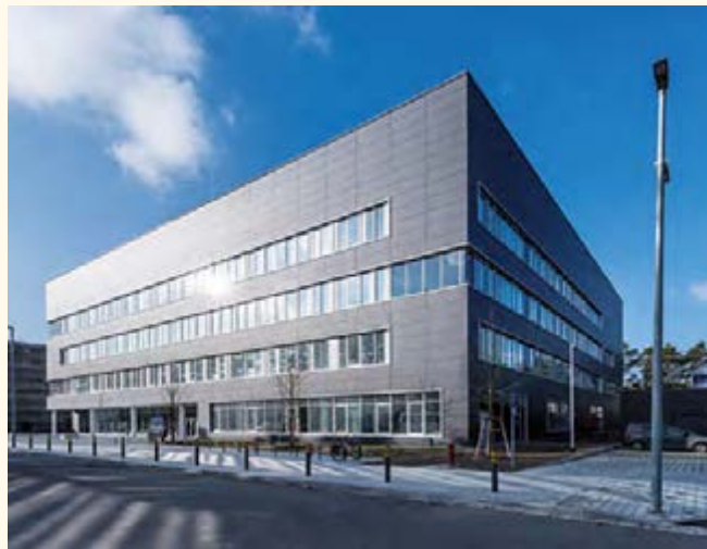
Neubau Interdisziplinäres Zentrum für Nanostrukturierte Filme (IZNF) EC EAM in Erlangen. Foto: Jürgen Krall
