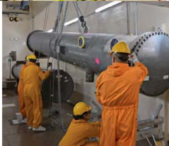
Rechts: Demontage eines Kühlers im Reaktorhilfsanlagengebäude.
