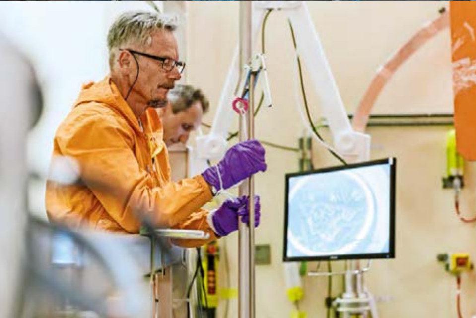
Ein Facharbeiter führt eine Unterwasserzerlegung mithilfe eines Manipulators durch.
