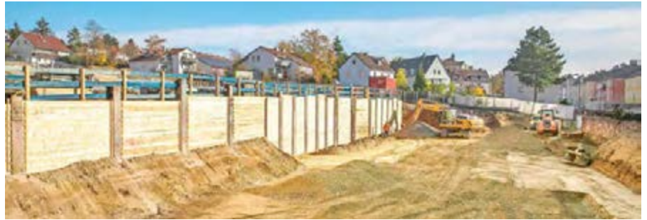
Die Baugrube in der Bossistraße – hier beginnen jetzt die Rohbauarbeiten der Häuser 9 und 10.
