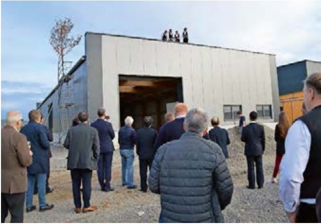
Bereits sechs Monate nach dem Spatenstich der CSC Bearing Europe wurde der nächste Meilenstein erreicht: Im Beisein zahlreicher Gäste, erfolgte im Oktober der feierliche Richtspruch. Foto: CSC
