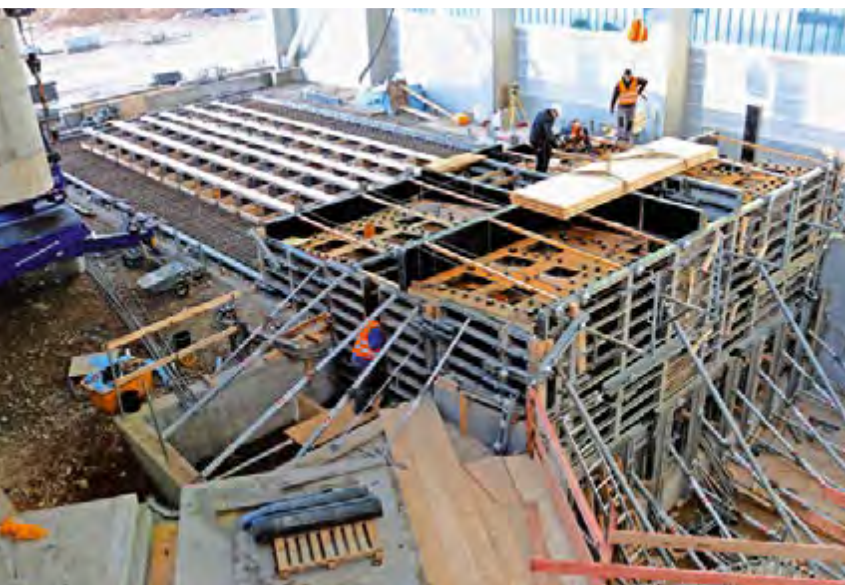
Gigantisch: Der Sockel für den riesigen SKF-Prüfstand mit Schwerpunkt „Windenergie“ wiegt rund 3.000 Tonnen.
