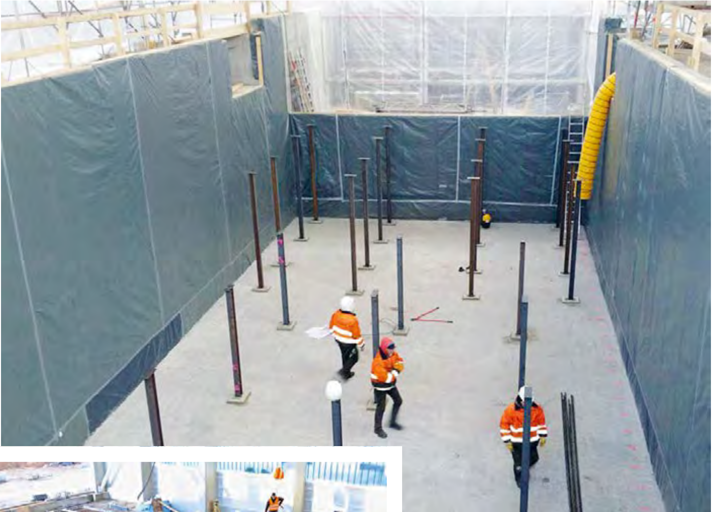
Gigantisch: Der Sockel für den riesigen SKF-Prüfstand mit Schwerpunkt „Windenergie“ wiegt rund 3.000 Tonnen.
