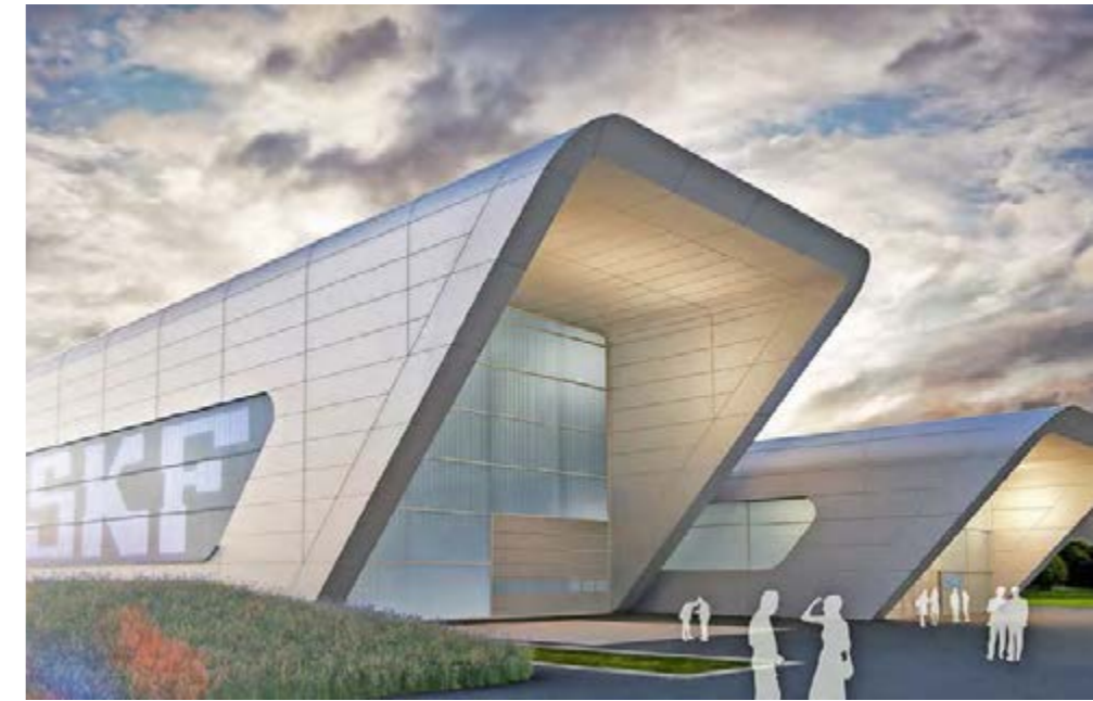
„Werk 3“, wo das leistungsfähigste Großlager-Prüfzentrum der Welt im Jahr 2017 seinen Betrieb aufnehmen soll.
