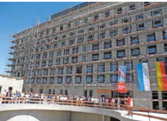
Richtfest im TGZ-Neubau. 06
